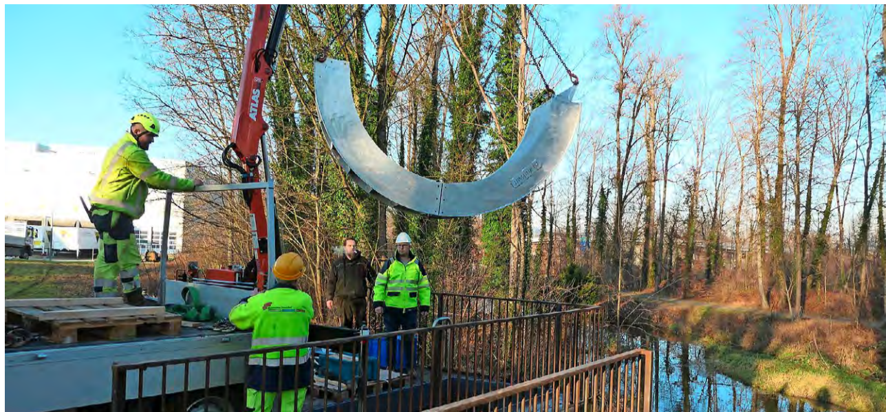
Anlieferung des oberen Teils des Wasserrads, das im ganzen einen Durchmesser von 2.70 Meter hat.
